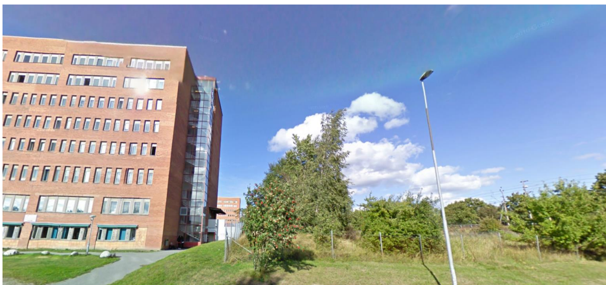
Figur 6. Fastigheten 2:2583 i dagsläget sedd från Frihetsvägen, i riktning norrut. Mäljarbanan skymtar till höger i bild.
